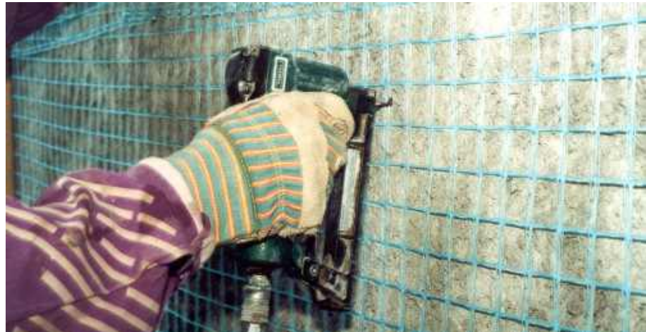
Bild 16: Fixieren von S&P mesh mit Haftklammern
