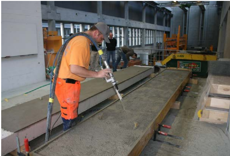
Bild 9: Applikation S&P ARMO-System
