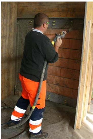
Bilder 26 / 27: Applikation des S&P ARMO-System
