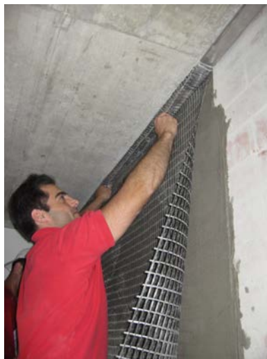
Bilder 28 / 29 / 30: seismische Verstärkung sowie Verankerung eines Mauerwerks mit S&P ARMO-mesh
