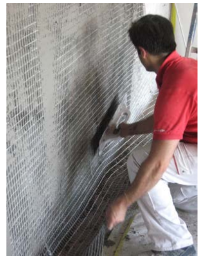
Bilder 28 / 29 / 30: seismische Verstärkung sowie Verankerung eines Mauerwerks mit S&P ARMO-mesh
