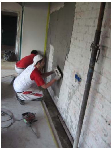
Bilder 28 / 29 / 30: seismische Verstärkung sowie Verankerung eines Mauerwerks mit S&P ARMO-mesh
