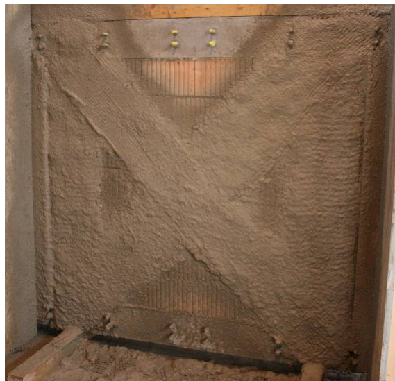
Bilder 26 / 27: Applikation des S&P ARMO-System
