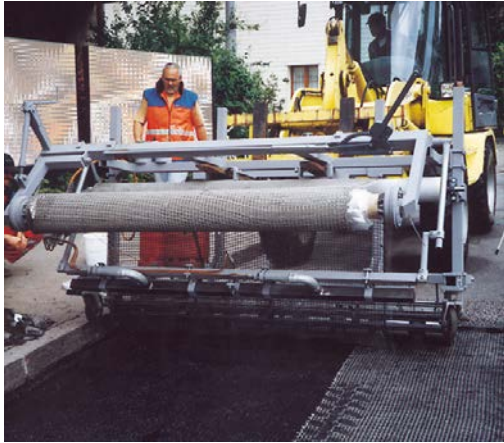
Bild 1: S&P Carbophalt G wird maschinell appliziert
