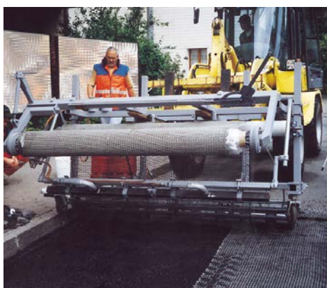
Bild 9: Einbau S&P Carbophalt G
