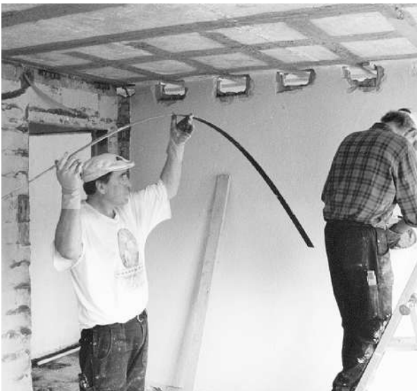
Bild 3: Einbau einer CFK-Lamelle
