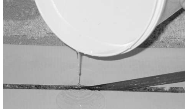
Bild 11: Auftragen des Klebers
