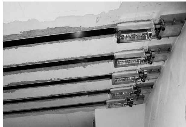
Bild 15/16: Das neue Vorspannsystem ist sehr leicht, da mehrheitlich aus Aluminium.
