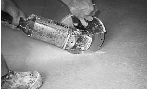
Bild 10: Einschlitzeln der Betonoberfläche
